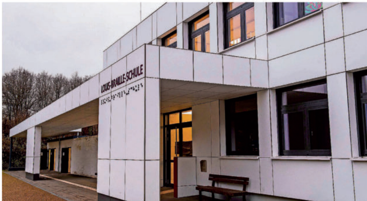
Eine schöne Fassade am Neubau der Louis-Braille-Schule, aber das Weiß blendet die sehbehinderten Schüler extrem. Um solche Planungsfehler bei der neuen Mehrzweck-Sporthalle zu vermeiden, soll frühzeitig ein Informationsaustausch zwischen den Planern und Machern auf der einen Seite, und den Schülern, Lehrern und Eltern auf der anderen Seite stattfinden.
